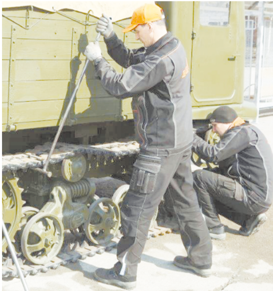
Слесари регулируют натяжение гусениц транспортного трактора СТЗ-5
